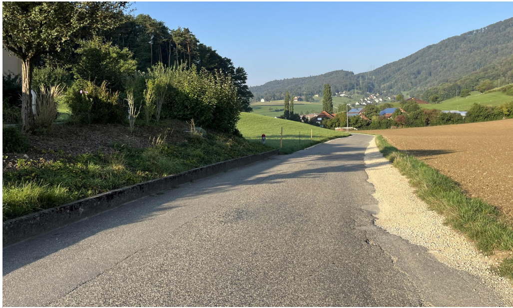
Abbildung 15: Mahrenstrasse bei Liegenschaft Nr. 103 (GB Nr. 2048), Blickrichtung West
